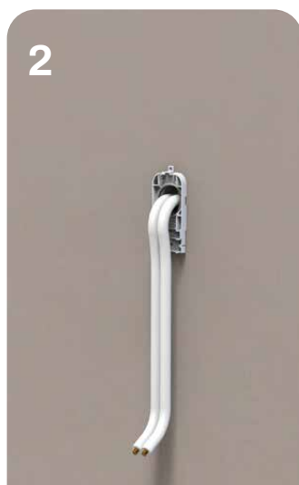
2 Inserire nel foro a muro le linee frigorifere e il cavo di alimentazione
