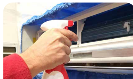
Pulizia batteria senza telo di protezione
