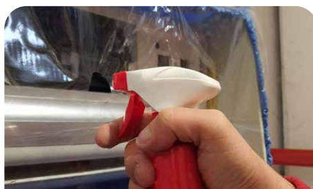
Pulizia batteria tramite foro inserimento spruzzino
