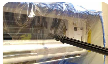
Pulizia batteria tramite foro inserimento macchina per pulizia
